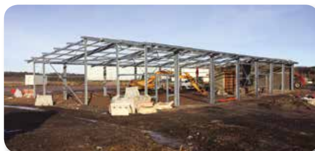
Boucherie Charcuterie Au Fumoir Vosgien (en cours de construction)
