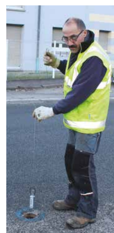
Pose d'un logger
