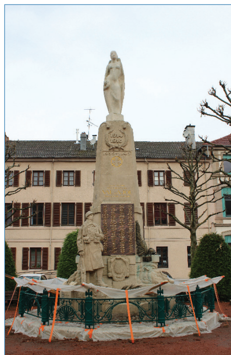
Le monument en cours de rénovation
