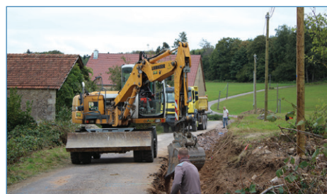
La route du Bolha en travaux
